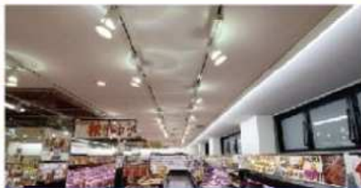
2019年2月のリニューアルで照明設備を100%入れ替え、天井からLEDへと変更した。それにより電気代が前年比で6割削減となるなど、単に店内が明るくお洒落になっただけでなく、省エネ策でも大きな成果を挙げている。
