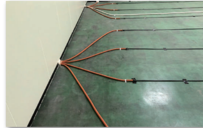
凍上防止ヒーター敷設
