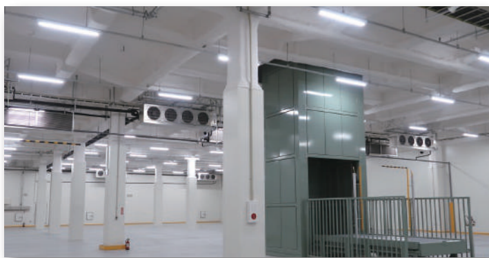
天井面ウレタン吹付工法
