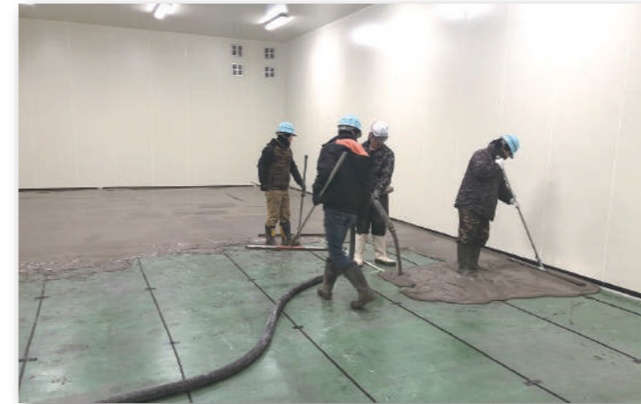
捨てコンクリート打設
