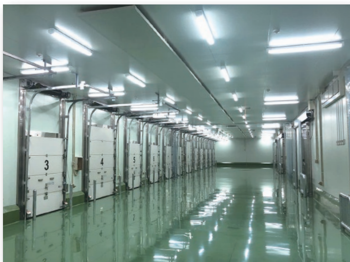
天井内ダクト
