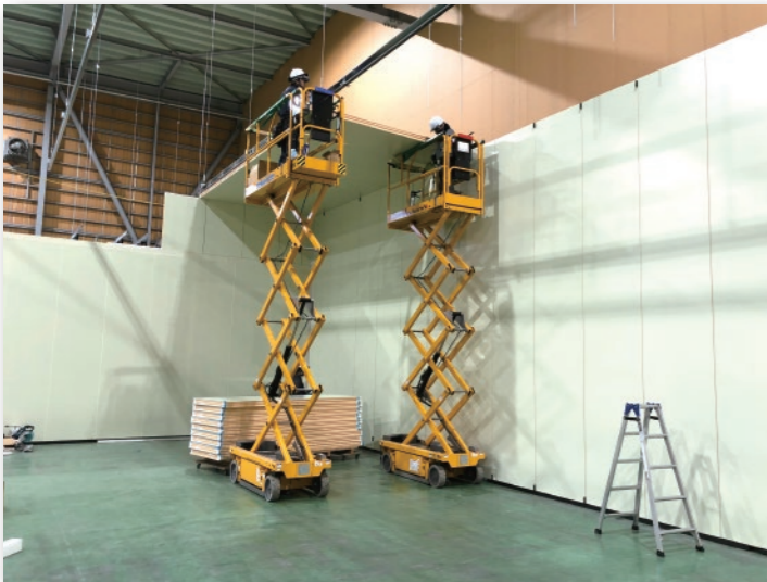
断熱パネル組立
