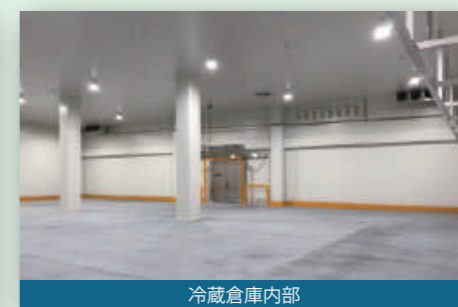
冷蔵倉庫内部
