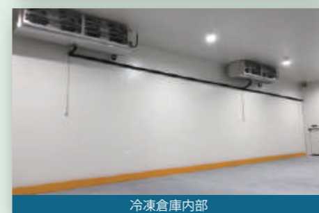
冷凍倉庫内部
