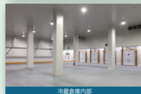
冷蔵倉庫内部
