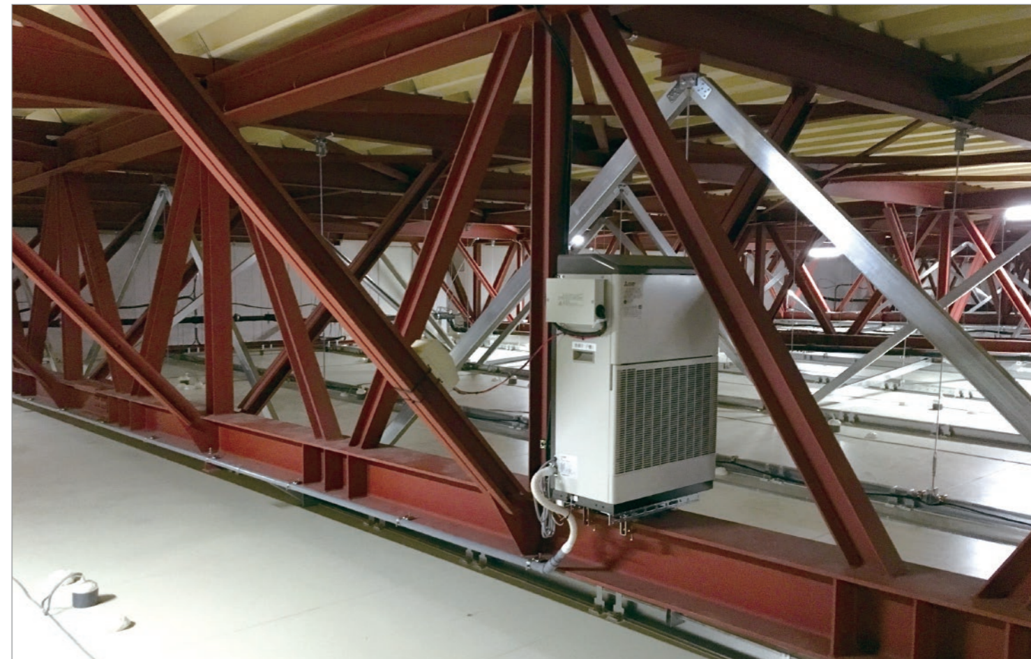
▲天井裏 除湿機設置 天井裏の湿度を軽減します
