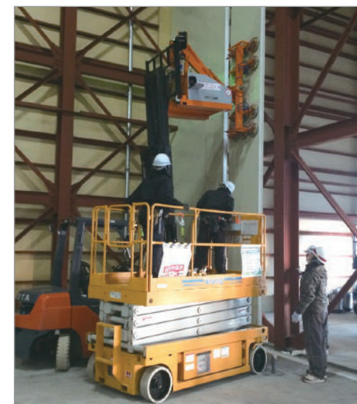
▲耐火パネル組立作業
