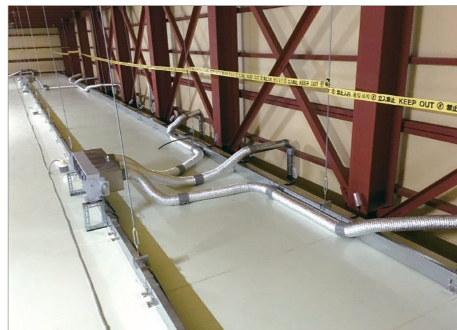
▲天井裏 除湿機設置 天井裏の湿度を軽減します
